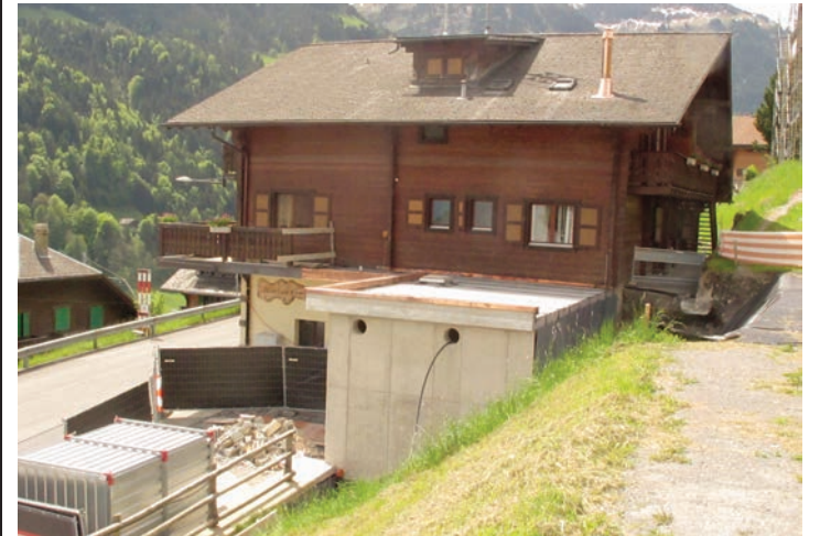
Le silo de 100 m où seront stockés les copeaux qui alimenteront le chauffage à distance a été érigé à côté de la maison de commune. LE NOUVELLISTE
